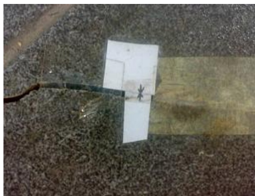
Gambar 1: Retakan lantai paling atas Plaza Andrawina (Sarita, 2013).
