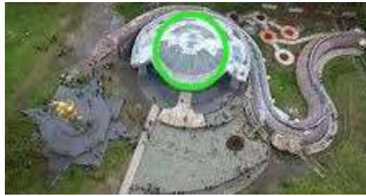
Gambar 9. Bentuk Lingkaran Pada Bangunan di TWI
