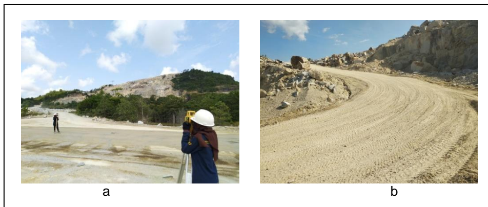
Gambar 2. Kondisi jalan tambang segmen S-W : (a) pada jalan lurus, dan (b) pada tikungan
