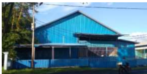
Gambar 6. Gedung Coldstorage yang disediakan DKP
