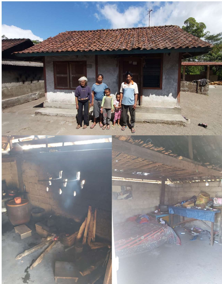
Gambar 1 Dokumentasi kondisi rumah sebelum perbaikan
