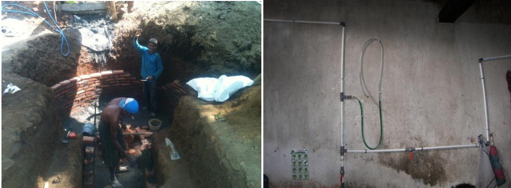
Gambar 2. Pembuatan digester fixed-dome serta instalasi biogas di Desa Sekarmojo
