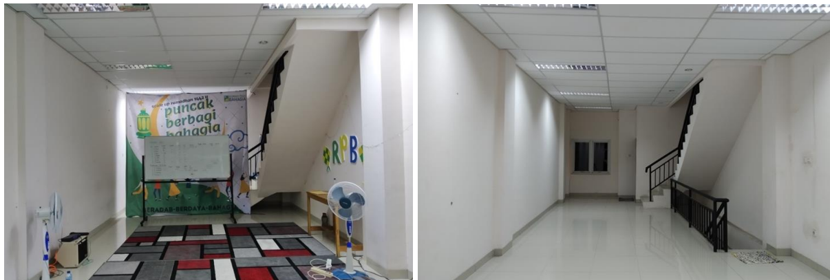
Gambar 2. Kondisi interior Rumah Pagi Bahagia lantai 1 (kiri) dan lantai 2 (kanan) (Sumber: Tim PKM, 2021)
