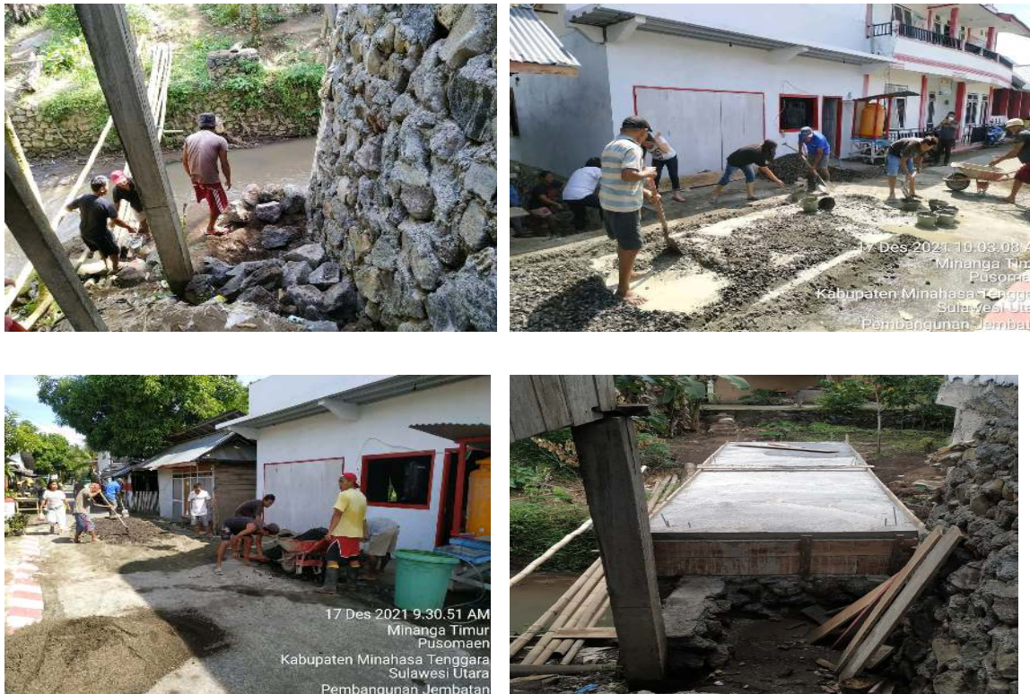
Gambar 6. Kegiatan pembangunan jembatan akses anak sekolah
