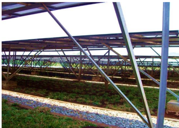
Gambar 4a Konstruksi penopang
