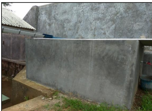
Gambar 3 Bak Penampung Air Hujan, terbuat Dari Pasangan Batu Bata
