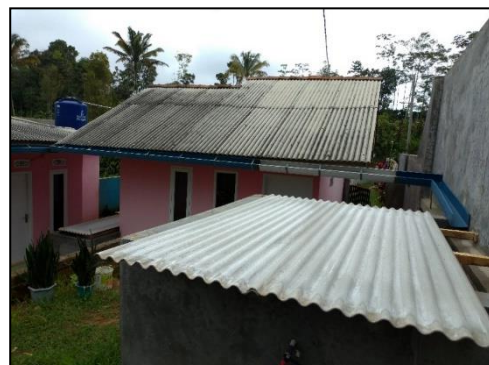
Gambar 4. Bidang penangkap air berupa atap dari bahan asbes
