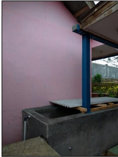
Gambar 5. Talang tegak untuk mengalirkan air ke bak penampung
