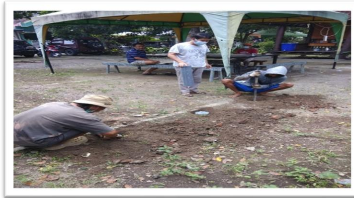
Gambar 5. Pengukuran dan Pelubangan Tanah Untuk Pembuatan Biopori
