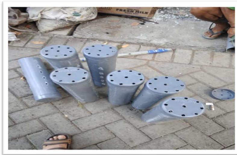
Gambar 3. Pembuatan Lubang Untuk Biopori
