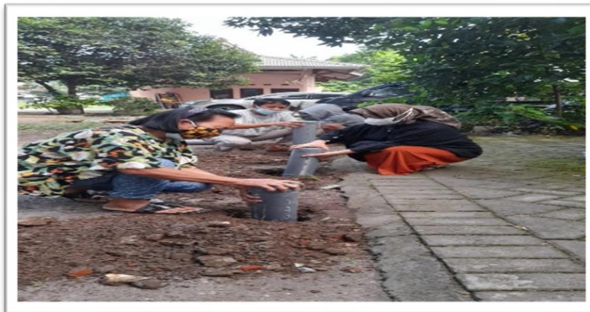
Gambar 4. Pemasangan Paralon untuk Lubang Biopori oleh ibu PKK
