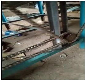
Gambar 4. Pengecekan Transmisi Mesin
