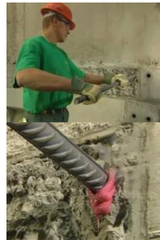
Gambar 3. Metode penyaluran dengan post-installed rebar connection [3]
