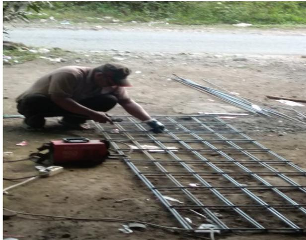
**Gambar 1. Pembuatan Rangka Kolam Terpal**
