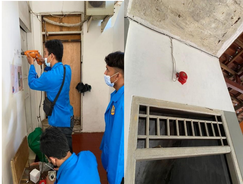
Gambar 5. Instalasi Bel Listrik
