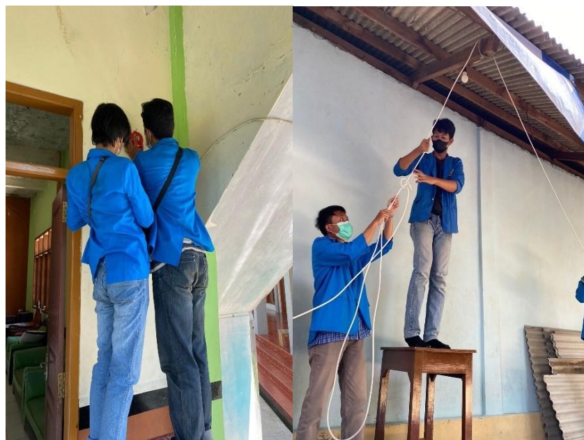
Gambar 6. Proses penarikan kabel listrik
