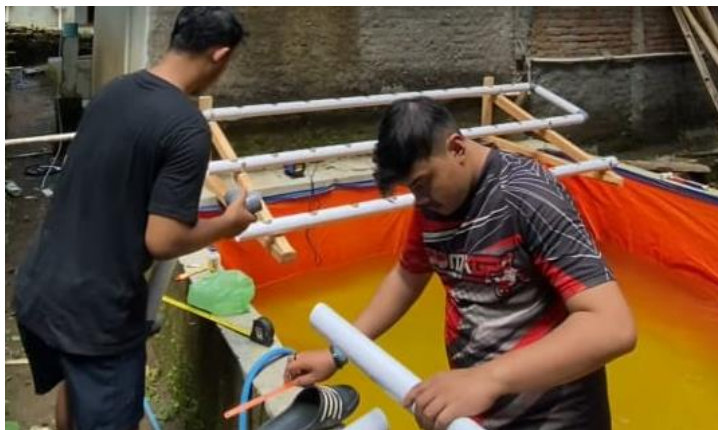
Gambar 7. Pemotongan paralon dengan bentuk letter S
