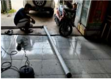
Gambar 1. pemotongan pipa sesuai lebar atap rumah ditambah 20 cm
