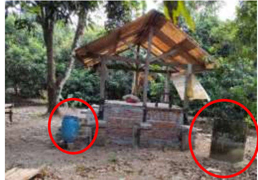
Gambar 4. bak penampungan berupa ember plastik kapasitas 40 liter dan bak penampungan air berupa gorong-gorong beton kapasitas 800 liter.
