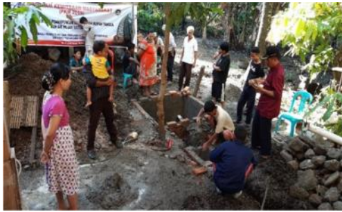
Gambar 3. Pembuatan bak kontrol
