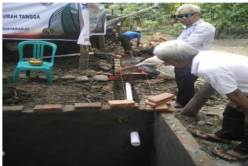
Gambar 4. Pemasangan pipa ke bak penampungan
