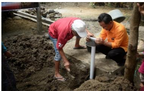
Gambar 5. Pemasangan pipa udara pada bak penampungan
