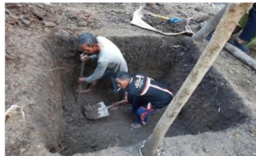
Gambar 1. Pekerjaan galian tanah
