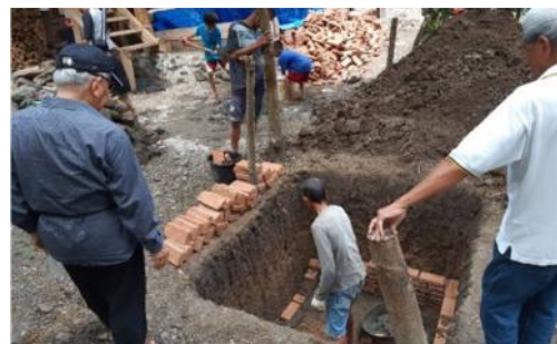
Gambar 2. Pemasangan batu merah
