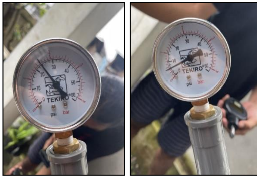
Gambar 4. Pengukuran Tekanan Air Menggunakan Manometer
