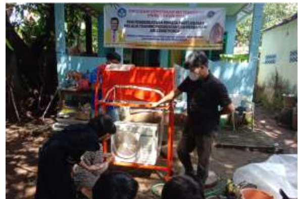
Gambar 3. Melatih dan mendampingi mitra melakukan perawatan bagian outdoor AC
