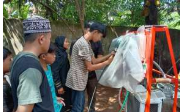
Gambar 2. Melatih dan mendampingi mitra melakukan perawatan bagian indoor AC
