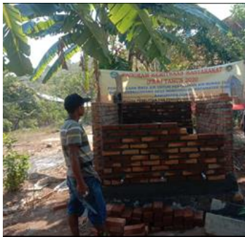
Gambar 5. Bak Penampungan Air
