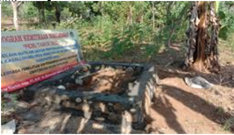
Gambar 4. Tahap awal pembuatan bak penampungan air
