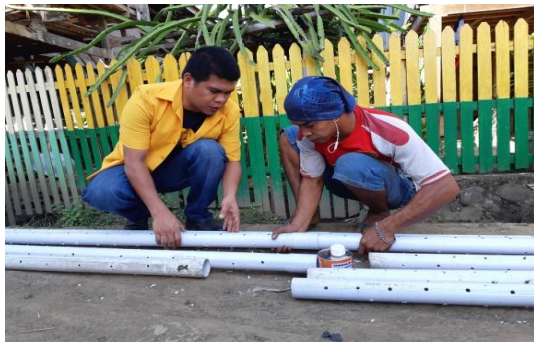
Gambar 6. Mempersiapkan alat dan bahan sumur bor sistem pipa imbuh
