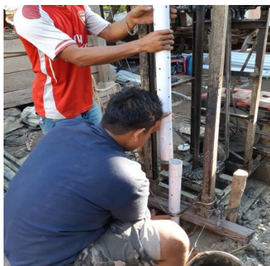
Gambar 9. Melatih mitra melakukan pemasangan pipa sumur bor sistem pipa imbuah
