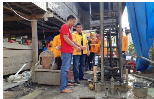
Gambar 8. Melatih mitra melakukan pengeboran sumur bor sistem pipa imbuh
