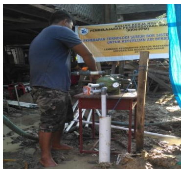
Gambar 10. Melatih mitra melakukan pemasangan mesin pompa air pada sumur bor sistem pipa
