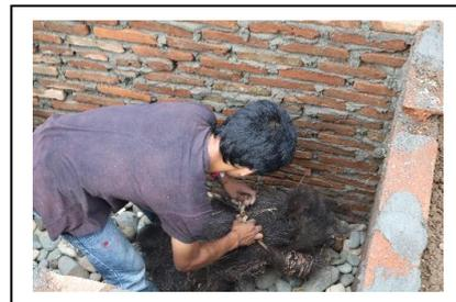
Gambar 3. Pembuatan tangki septik/peresapan di Desa Tadampalie
