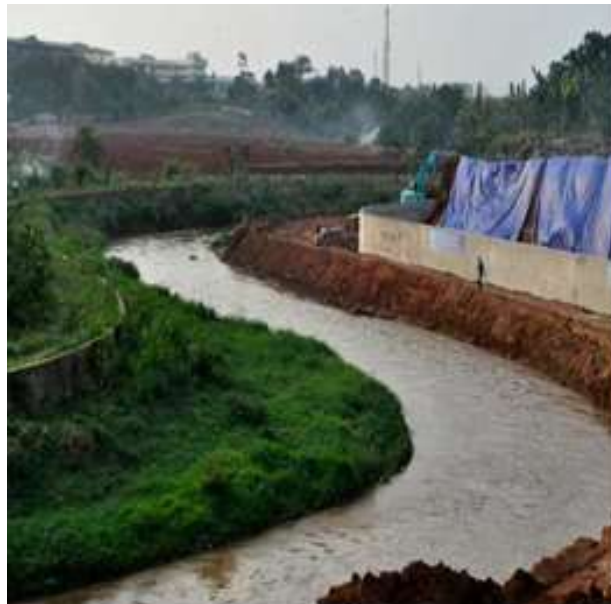
Gambar 5. Pekerjaan Perkuatan Tebing
