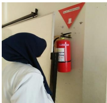
Gambar 3. Letak APAR kurang mudah dijangkau
