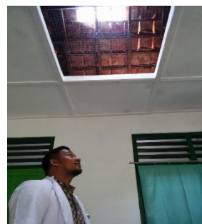
Gambar 6. lubang di atap poli
