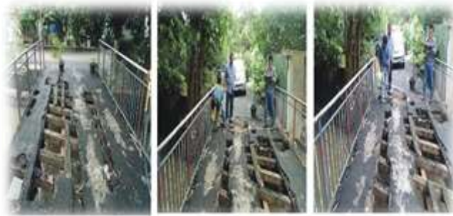
Gambar 26. Jembatan Pondok Karya 10
