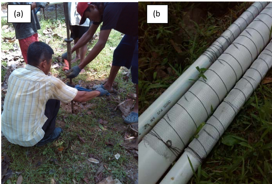
Gambar 4.(a) Pembuatan lubang sumur Siphon menggunakan bor tangan, (b) Casing sumur Siphon yang terbuat dari paralon yang telah diberi screen dan kawat ram nyamuk.
