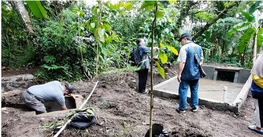
Gambar 4. Konstruksi sipil bendung/ intake
