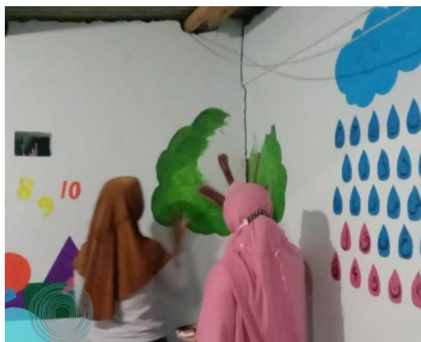
Gambar 4. Pengecatan Dinding Ruang Baca
