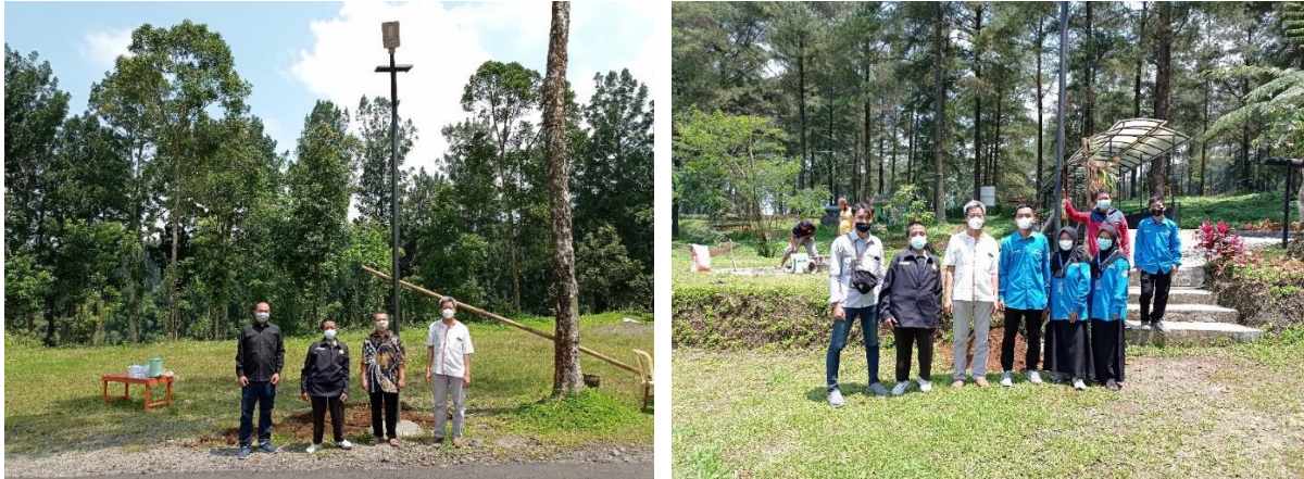
(a) (b) Gambar 4. Lampu penerangan jalan umum yang telah terpasang
