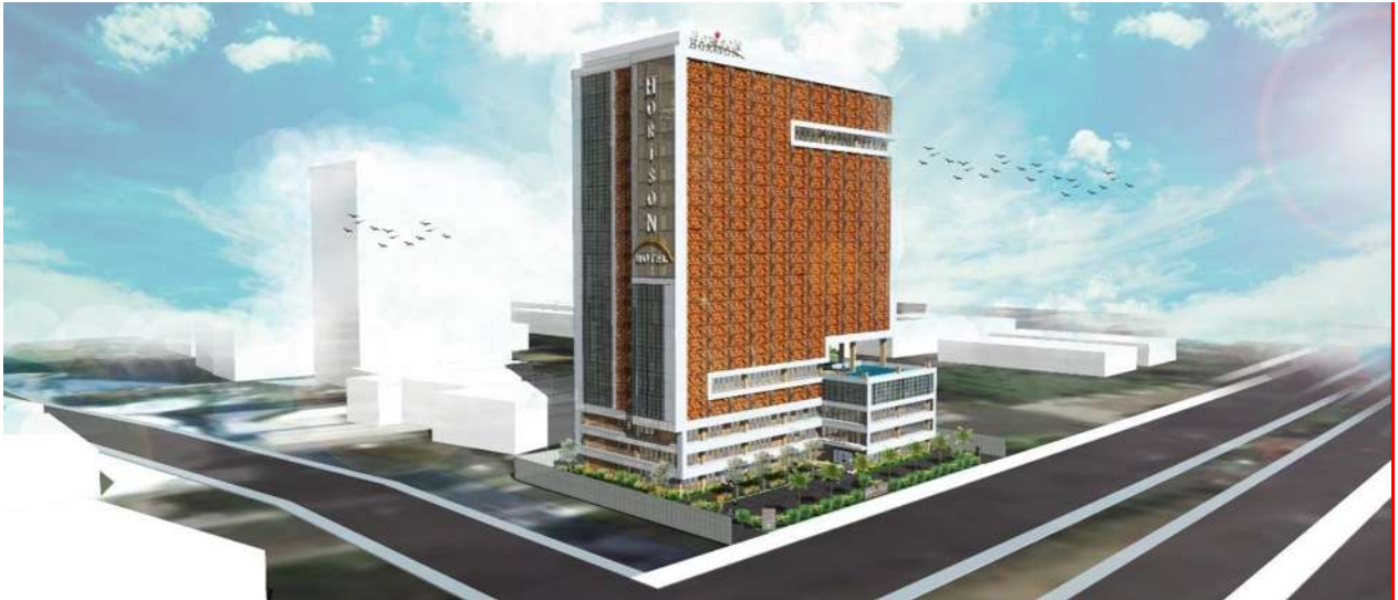
Gambar 5. Penerapan Secondary Skin Motif Batik Jawa Timur pada Bangunan (Sumber: Hasil desain, 2014)
