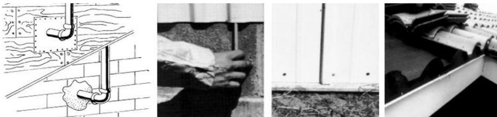
Gambar 1. Sistem *Rodent Proofing* dan *Bird Stopp* pada Bangunan Industri
