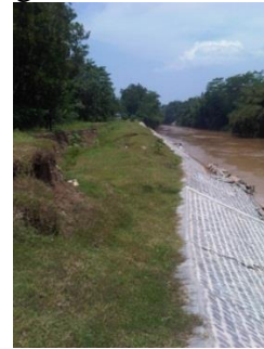
Gambar 9 Kondisi dinding penahan eksisting peninjauan lapangan
