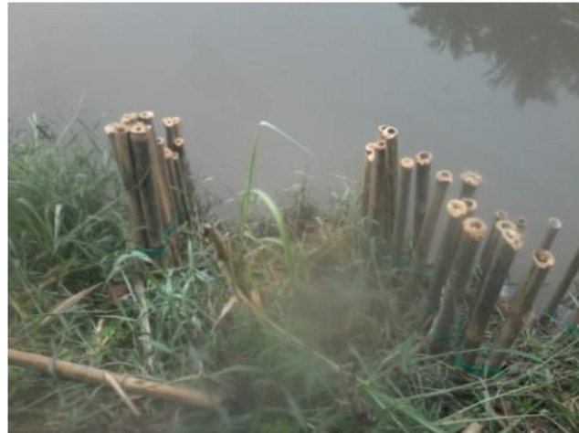
Gambar 3. Krib Bambu
