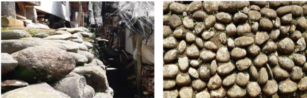
Gambar 1. Formasi Susunan Batu Untuk Mengunci Tepi Lapisan Tanah (Peneliti, 2022) Ket. Kiri: Susuan Batu Menyamping. Kanan: Susunan Batu Dari Bawah ke Atas
