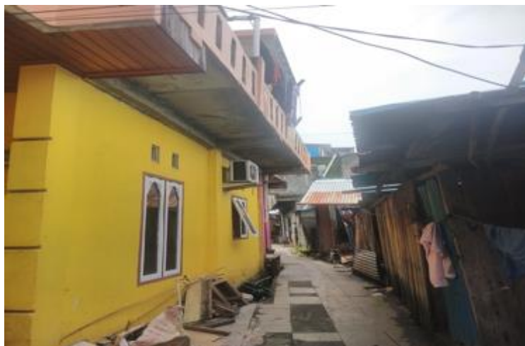
Gambar 1.b Kondisi Bangunan Pemukiman Kumuh Kelurahan Makassar Timur
