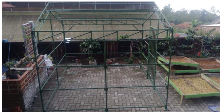
Gambar 3. Rangka Besi Bak Penjemuran Kopi Portabel
