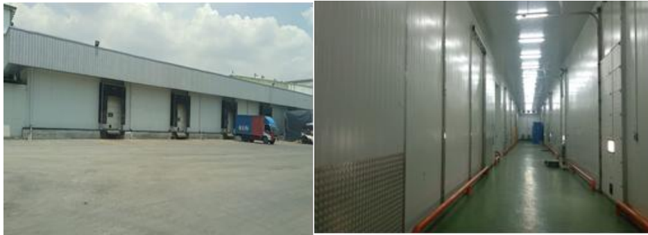
Gambar 1. Cold storage di Pelabuhan
