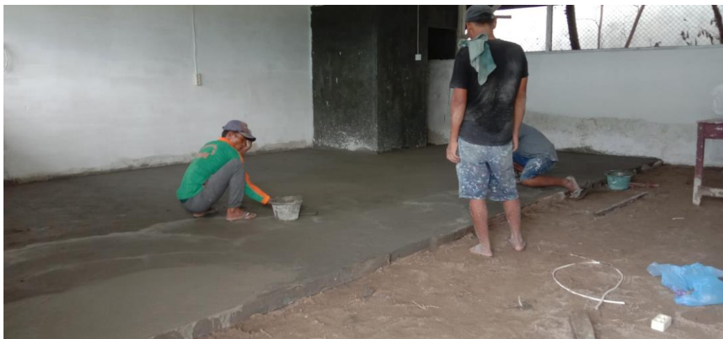
Gambar 4: Pek. Cor Lantai Kerja
