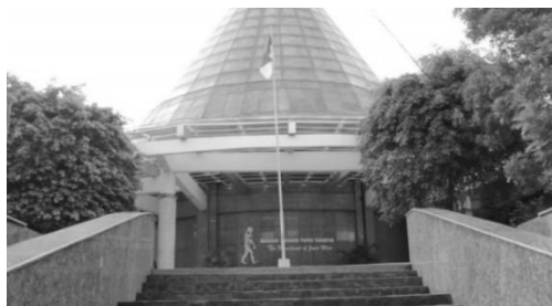
Gambar 13. Scene 56 – Koridor tangga menuju gedung Ruang Pamer 3, Taman, dan Gazebo Sumber : Dokumentasi Penulis
