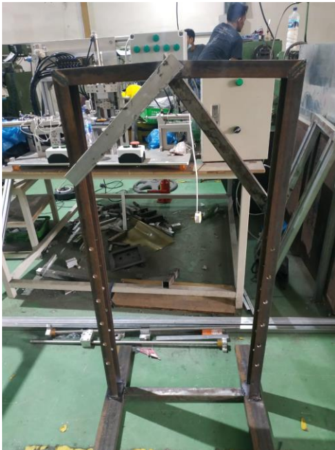
Gambar 1. Bending yang Terjadi pada Frame .
