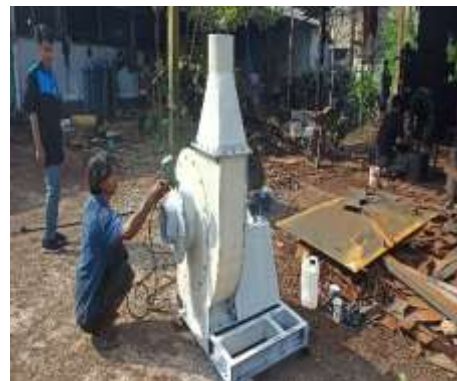
Gambar 2. Pekerja melakukan proses pengecatan blower .
