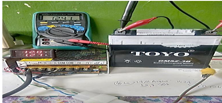
Gambar 10. Suplai tegangan listrik dan arus pengisian ke akumulator dc internal.
