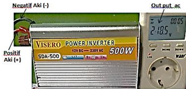
Gambar 6. Pengujian tegangan listrik ac pada out put inverter.
