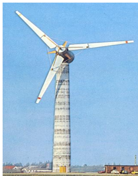
Gambar 2. Turbin angin Nibe termasuk jenis sumbu poros horisontal dengan jumlah sudu 3 buah
