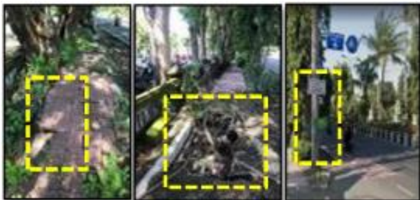
Gambar 6. Pedestrian Ways yang Rusak dan Signage Tidak Menggunakan Langgam Arsitektur Bali
