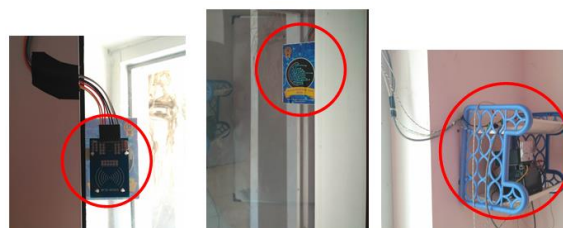
Gambar 15. Pemasangan RFID Reader dan Dudukan Alat
