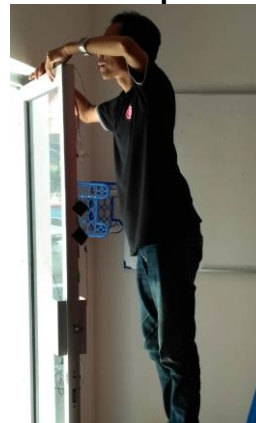
Gambar 13. Pemasangan Kabel antar Komponen
