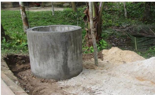
**Gambar 3.** Badan sumur telah siap untuk di lantai dan diberi pagar supaya dapat digunakan.
