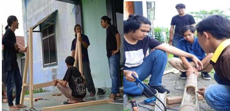
**Gambar 2.** Perakitan Rak dan pelubangan bambu
