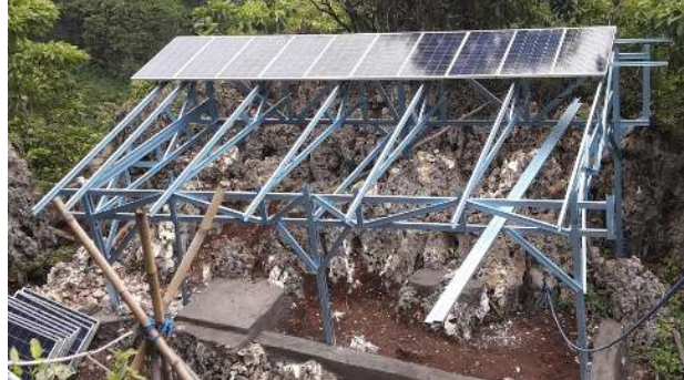
Gambar 8 Pemasangan Panel Surya Sumber: Dokumentasi Tim
