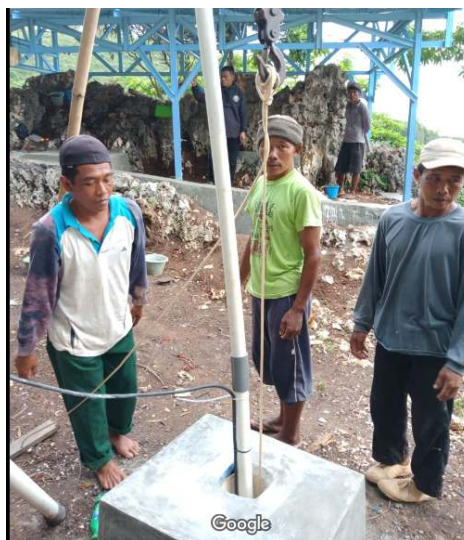
Gambar 9 Pemasangan Pompa Air Sumber: Dokumentasi Tim
