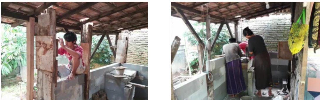
Gambar 5. Pelaksanaan Perbaikan Ruang Dapur
