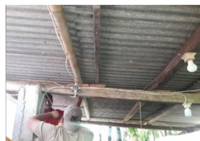
Gambar 2. Pelaksanaan instalasi listrik
